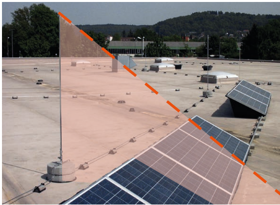
Bild 12 Ermittlung des Schutzraumes mittels Schutzwinkelverfahren
